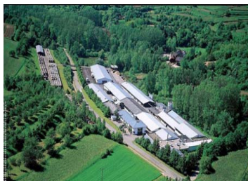
Das Hiller-Firmengebäude in badischen Kippenheim
